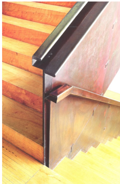
Escalera del Gobierno Civil, 1957
